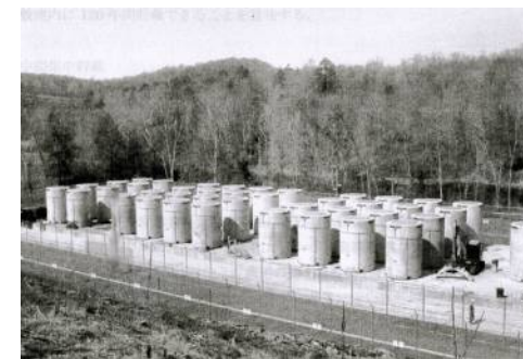
コネティカット・ヤンキー原子力発電所。41のキャスクに4122トンの使用済燃料が入っている。
