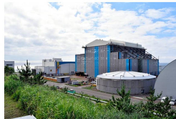
建設中の大間原発(朝日新聞ホームページより)
