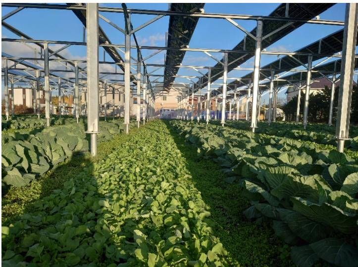
パネルを高いところに間隔を空けて設置しているので、積雪が多い年でも除雪する必要がなく、雪の重さで壊れたパネルは全くない。
